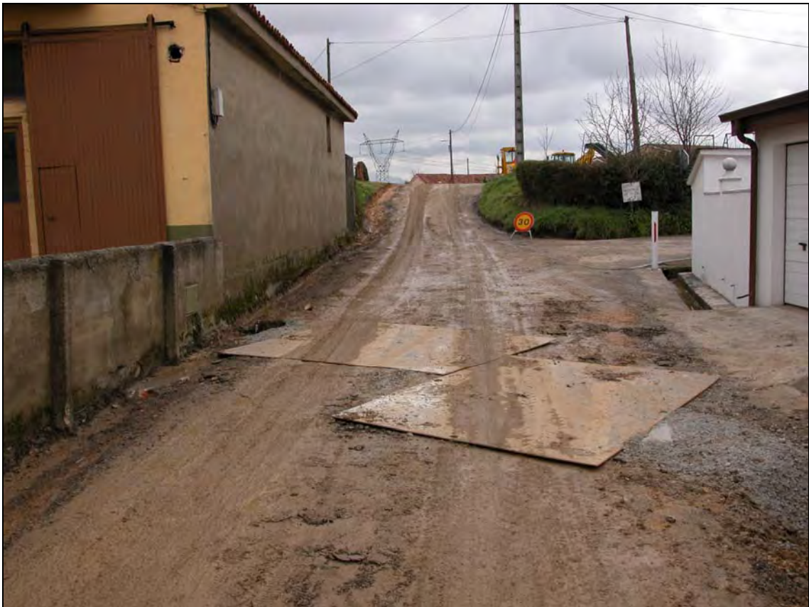
Foto 38.- En el momento de realizar este estudio el camino se encontraba en obras.
