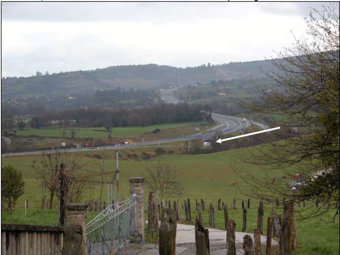
Foto 6.- Desde El Valle se aprecia perfectamente el trazado de la Autovía Minera, que corta el valle y el antiguo Camino de Ferrera, repuesto mediante un paso inferior (donde indica la flecha).
