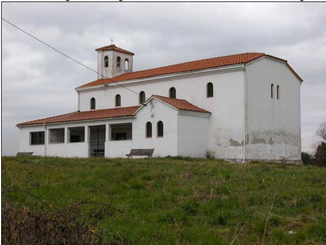
Foto 36.- La iglesia actual de San Miguel carece de interés patrimonial.
