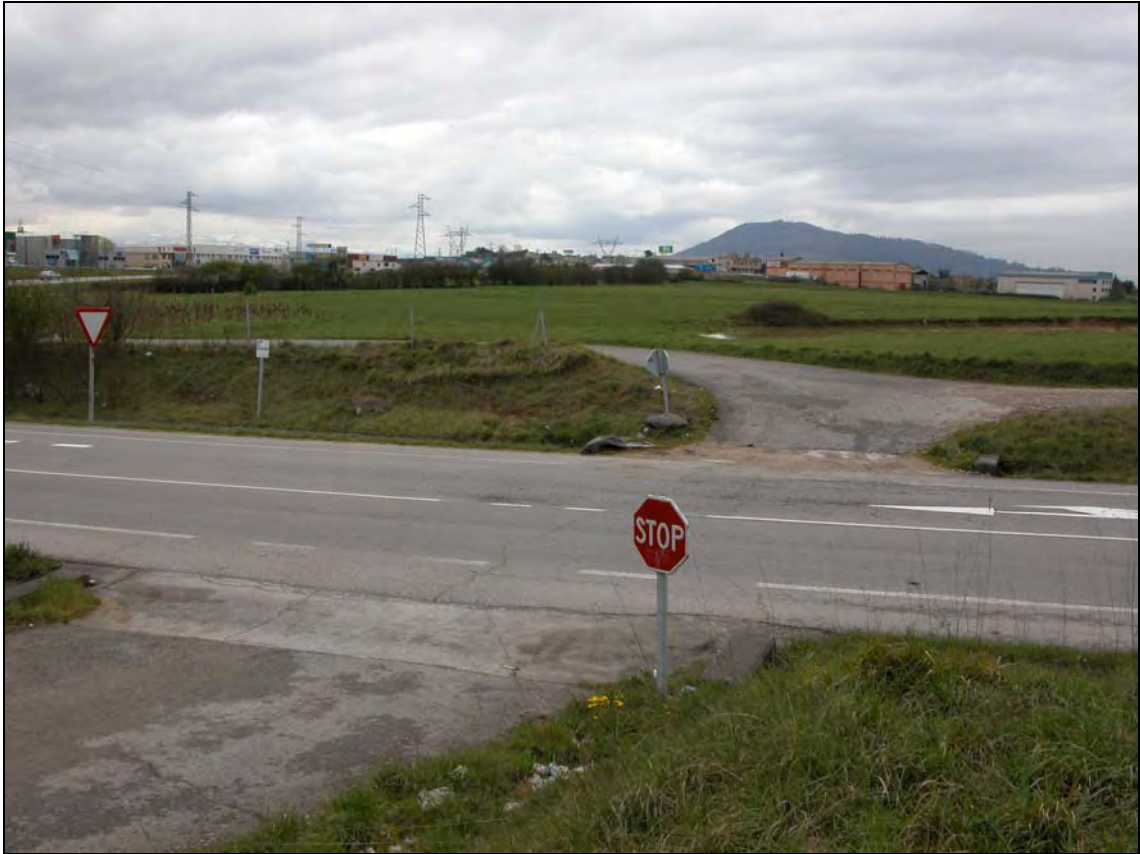
Foto 42.- Este camino de servicio atraviesa el ramal que enlaza la AS-17 con la Autovía en este punto.
