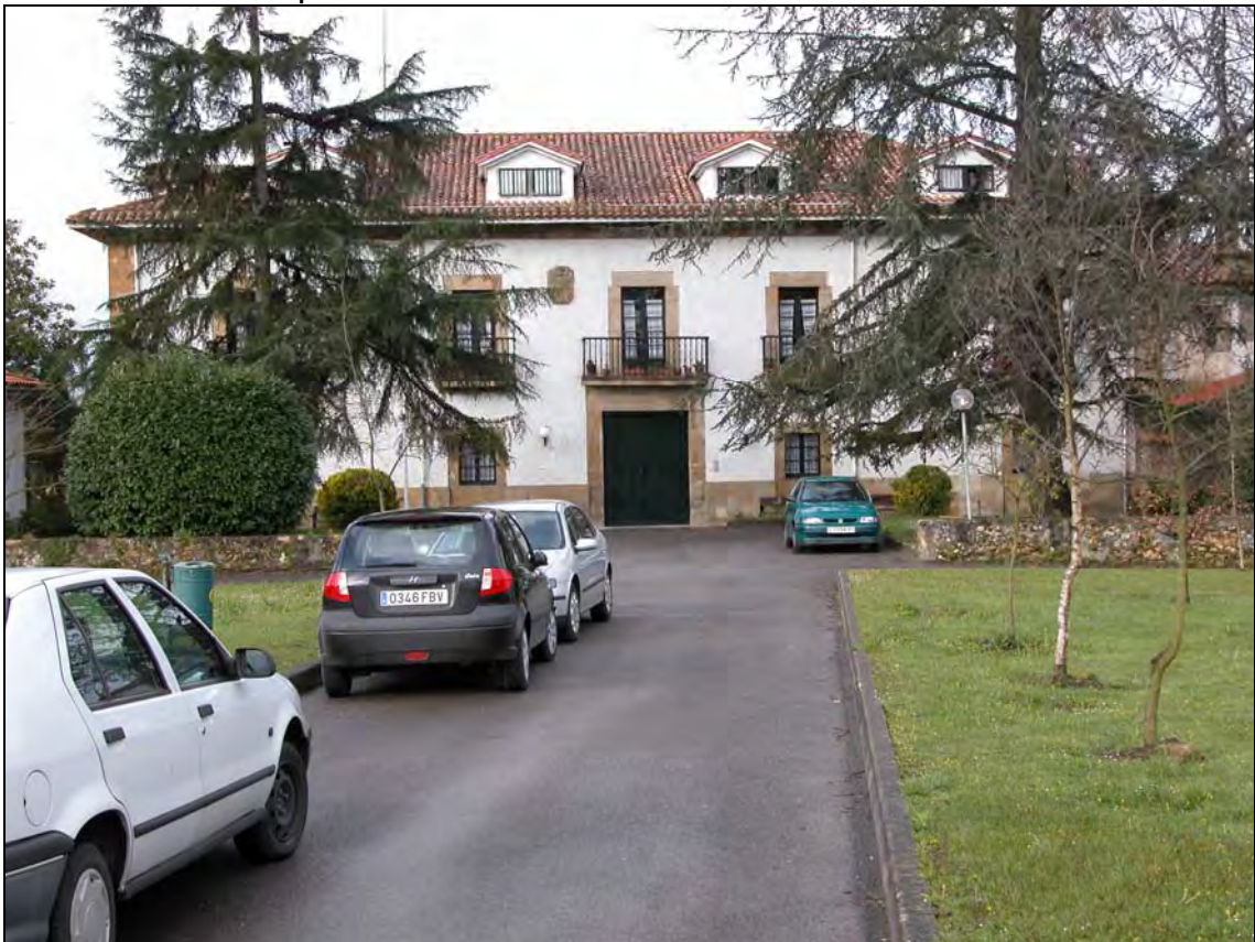
Foto 18.- Imagen del Palacio de Miraflores, completamente restaurado, si bien conserva el aspecto de antigua casona.
